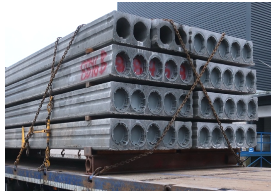
Esimerkki valjassidonnasta HI-palkin edestä vasemmalla ja oikealla valjassidonta elementin sidontapisteen läpi.
