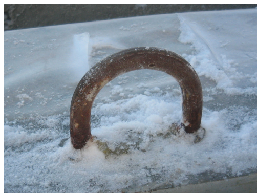
Kuva 11. Nostolenkki seinäelementissä.
