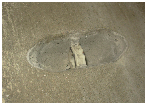
Kuva 12. Nostoankkurin varaus ja reikärauta elementissä. (Kuva: Peikko Finland Oy)
