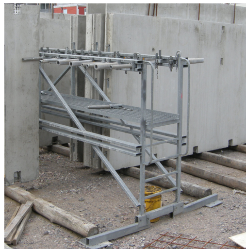
Kuva 10. Kampateline eli elementtifakki.
