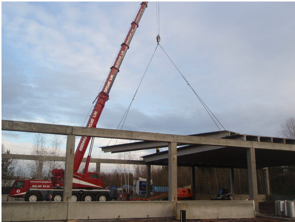
Kuva 32. TT-laatan nosto. (Kuva: Voller Oy)
