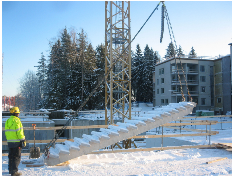
Kuva 34. Suoran porraselementin nostaminen, askelmien suojaus laudoilla.
