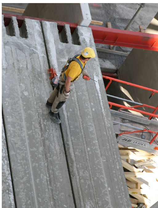
Kuva 36. Norjassa käytetty ontelolaattojen väliin kiinnitettävä turvaljaiden kiinnityspiste.
