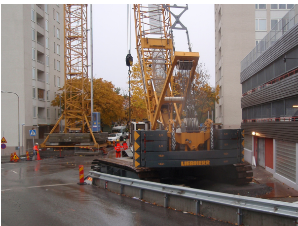
Kuva 2. Tela-alustainen ristikkopuominosturi. (Kuva: Voller Oy)
