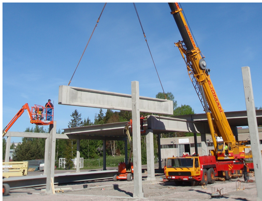
Kuva 28. Palkin nosto. (Kuva: Volleri Oy)
