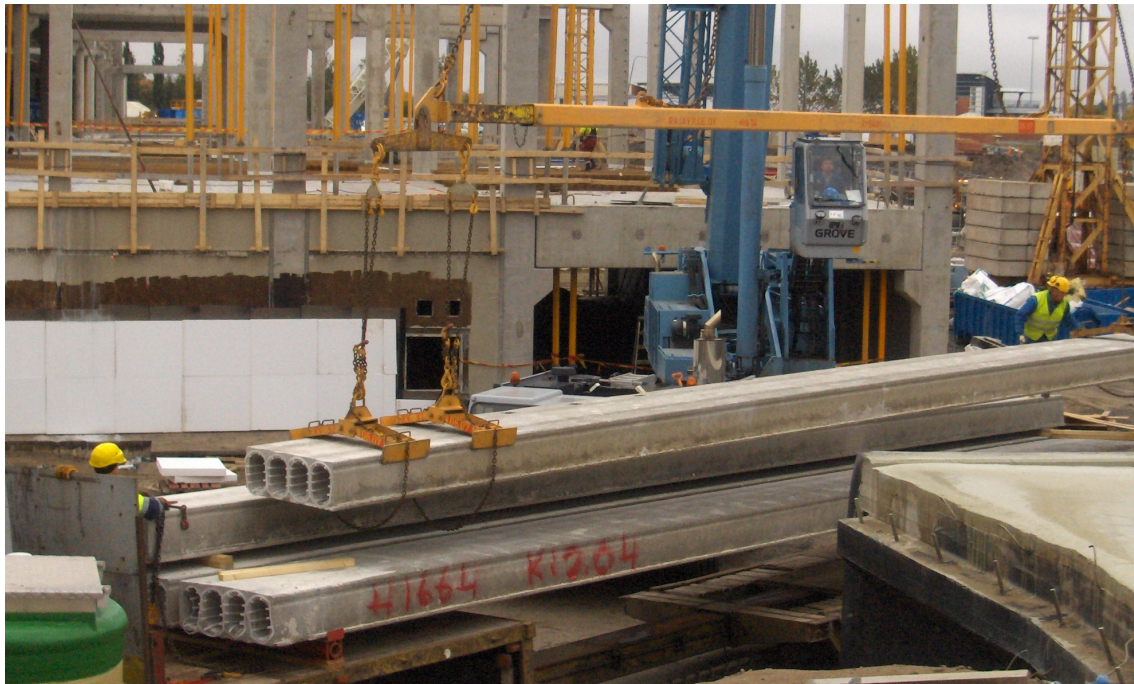
Kuva 20. Ontelolaatan nosto nostopalkilla ja tuplasaksilla.
