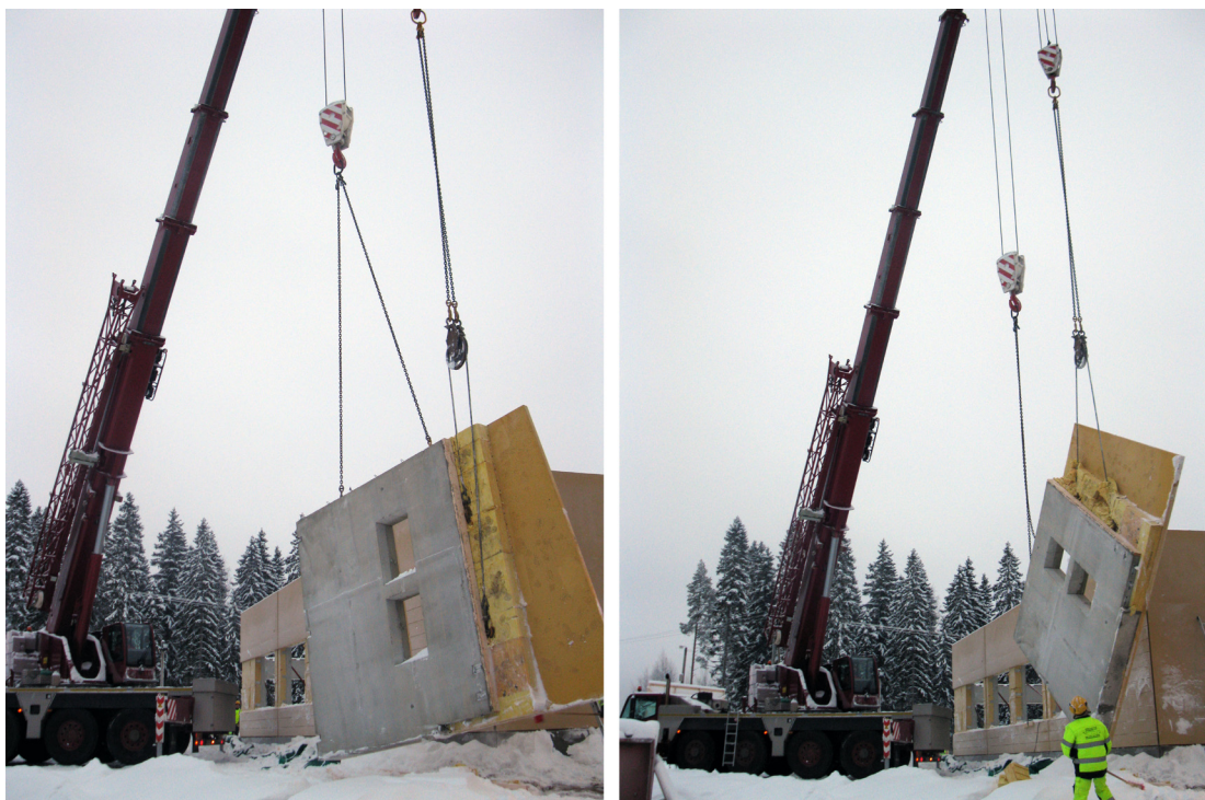
Kuva 40. Elementin kääntö kääntöpyörän avulla yhdellä ajoneuvonosturilla.
