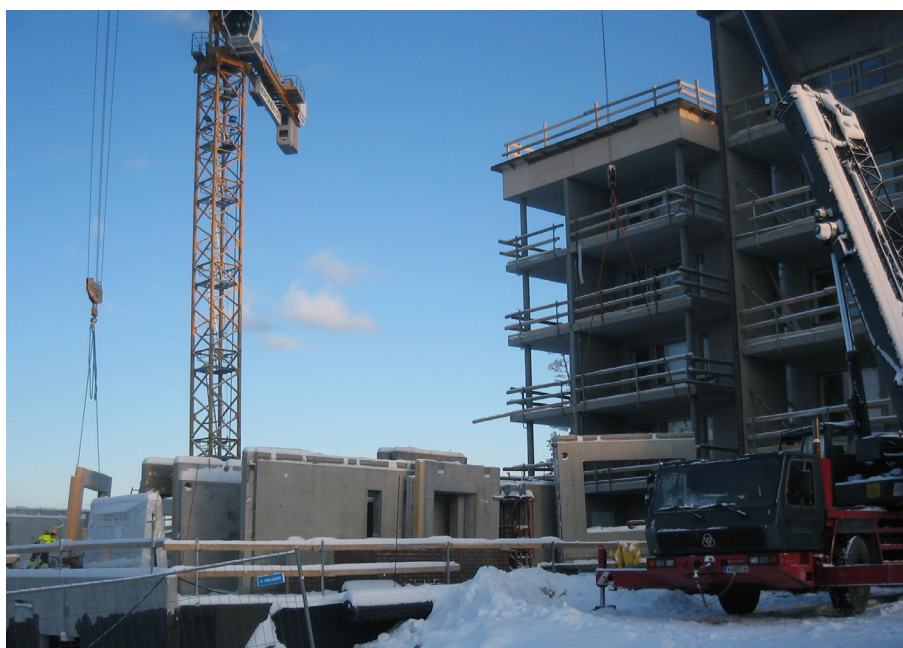
Kuva 1. Seinäelementin nosto torninosturilla.
