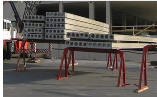
Kuva 8. Ontelolaatat voidaan varastoida erillisten telineiden päälle.
