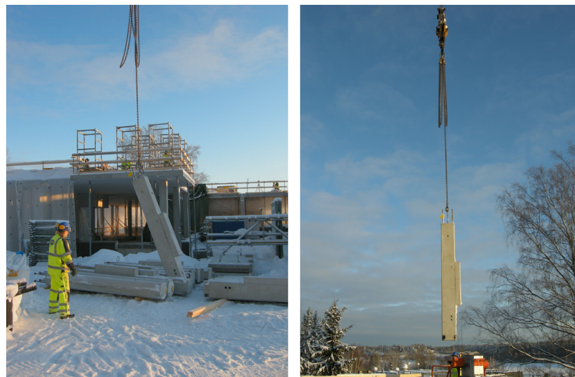
Kuva 27. Pienen pilarin nosto pilarin päässä olevasta nostoankkurista yhdellä nostoraksilla.
