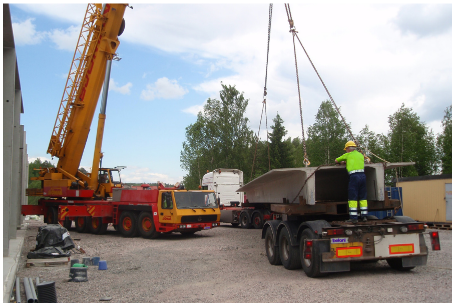
Kuva 7. TT-laatan nosto kuljetusautosta. (Kuva: Voller Oy)
