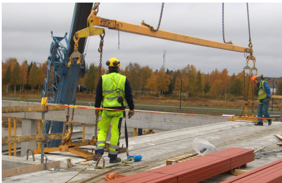
Kuva 30. Ontelolaatan nosto.
