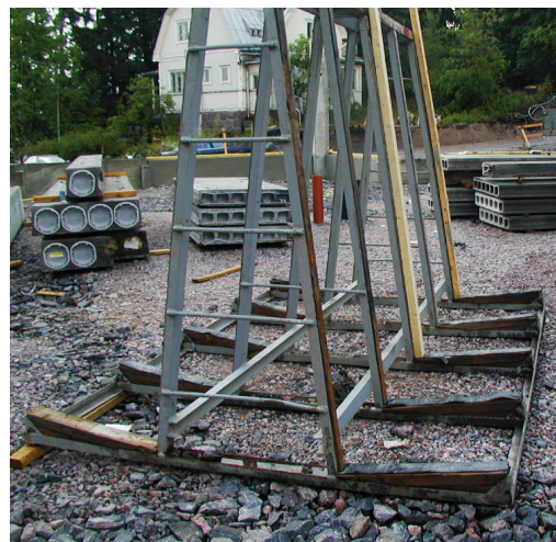
Kuva 9. Seinäelementit voidaan varastoida työmaalla esimerkiksi A-pukkiin. Elementit nostetaan A-pukeista pois vuorotellen kummaltakin puolelta, jotta telineen tasapaino säilyy.
