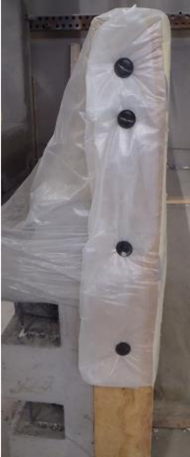
Kuva 5.4.1 Eristetyn sisäkuorielementin yläosa kutistemuovissa
