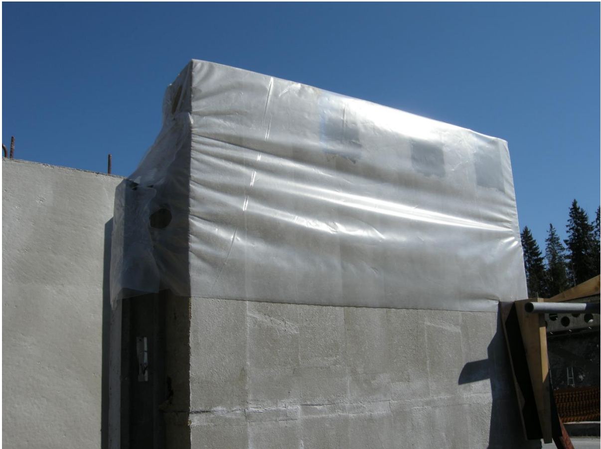
Kuva 5.3.1 Ohutrappauselementin yläosa kutistemuovissa
