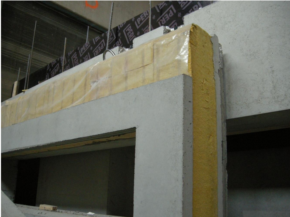
Kuva 5.1.1 Eristeen yläreunassa muovi
