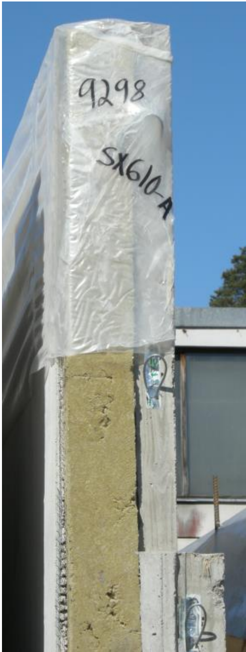
Kuva 5.2.1 Paksurappauselementin yläosa kutistemuovissa
