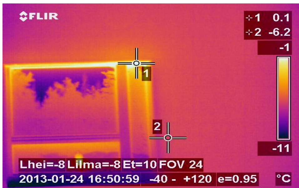
Kuvio 39. Lämpökamerakuva ulkoseinästä, rakennetyyppi US8.
