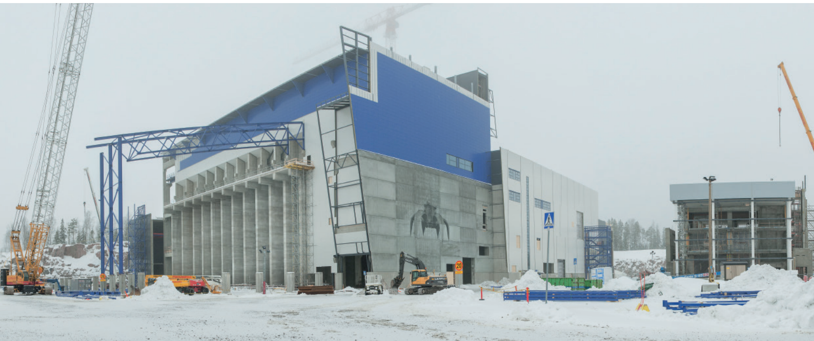
7 Työmaa helmikuussa 2013. Kauas näkyvä yksityiskohta on jätebunkkerin seinässä oleva valtava kahmarin kuva. Se on toteutettu graafisella betonilla.
