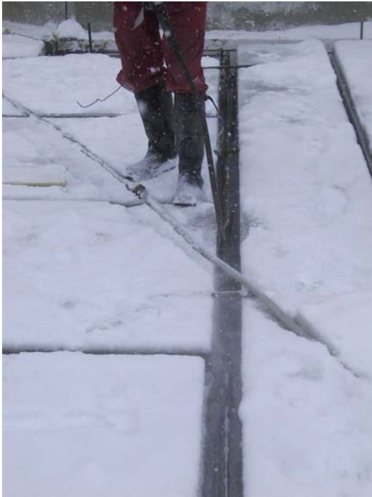
Kuva 6. Ontelolaattojen sauman puhdistusta paineilmalla.
