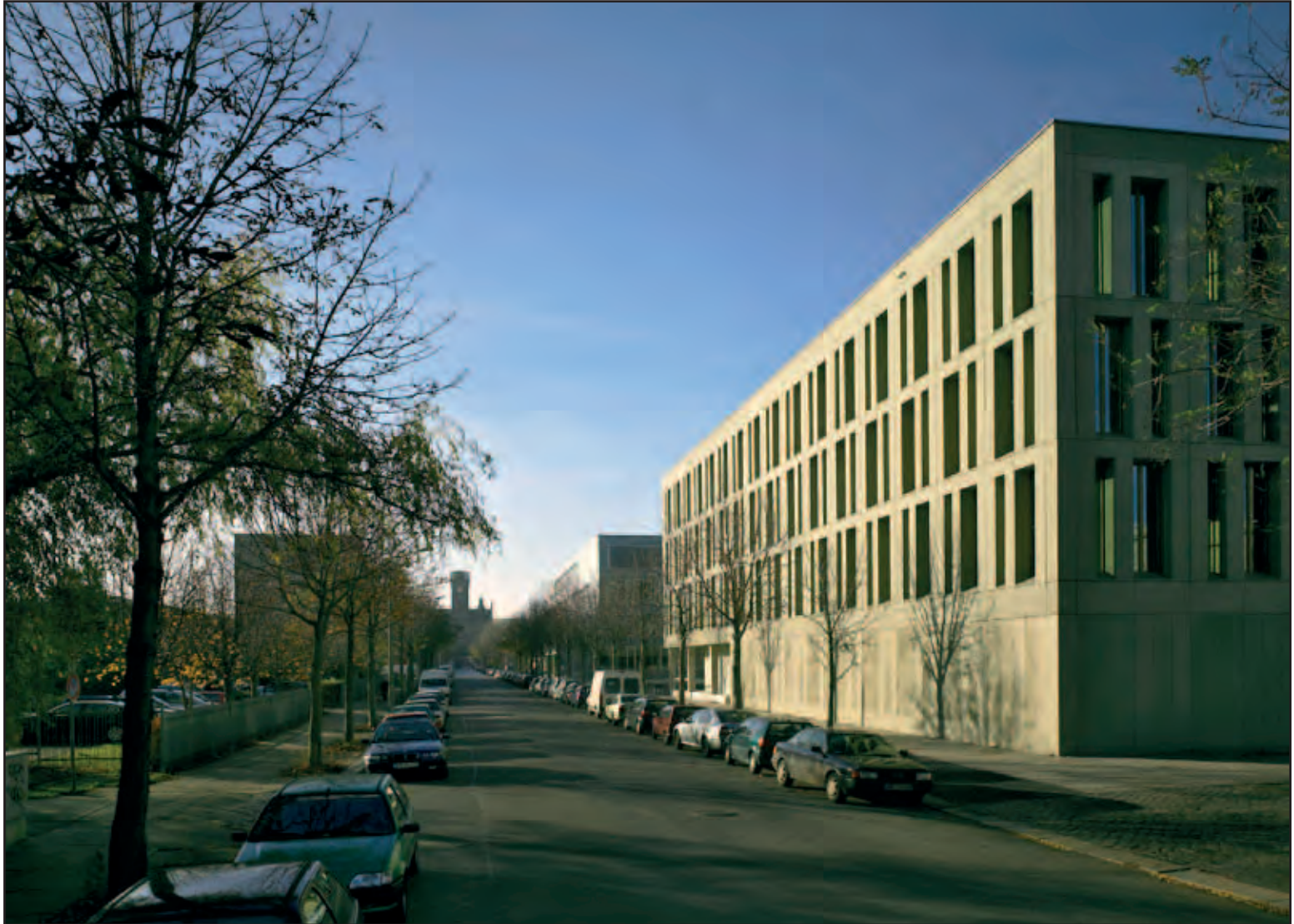
Dresdenin teknillistaloudellisen ammattikorkeakoulun kirjaston energiaratkaisuna on käytetty mm. aktivoitua betoniydintä. Arkkitehti: ReimarHerbst Architekten. Kuva: Lothar Sprenger.
