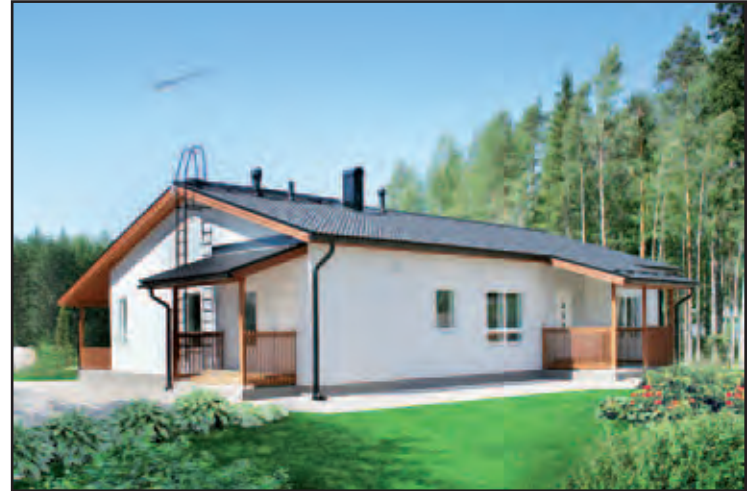
Tiivis betonielementeistä tehty passiivitalo (VTT:n mittaama ilmanvuotoluku n_{50} = 0,09 ). Kuva: Suutarinen-Yhtiöt.
