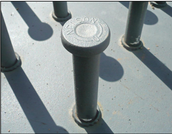
Kuva 3.2 Kannallinen tappiliitin hitsattuna kotelopalkin ylälaippaan.
