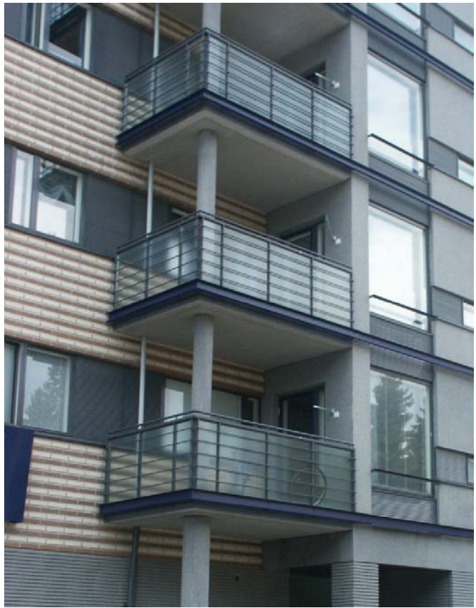
Kuva 11. Pilarin ja seinien varaan kannatettu parveke.
