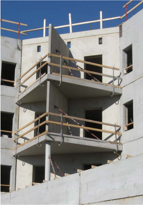
Kuva 10. Parvekkeet rakenteilla.
