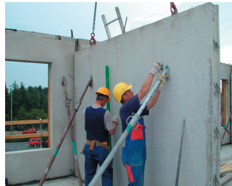
Kuva 8. Seinäelementit tuetaan vähintään kahdella säädettävällä elementtituella. Elementtitukien yläpäiden kiinnityspisteiden tulee olla elementin painopisteen yläpuolella. Korkeat seinäelementit, joissa elementtitukien kiinnityspistettä ei saada painopisteen yläpuolelle, on tuettava muuten riittävästi.
