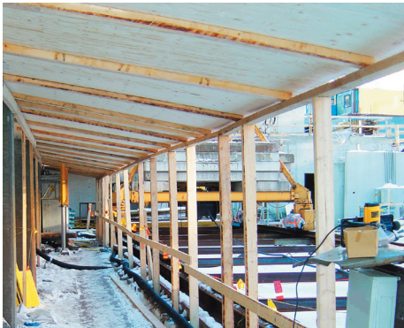
Kuva 10. Siisti työmaa on turvallinen. Työmaan kulkureiteille ei saa varastoida tavaraa.
