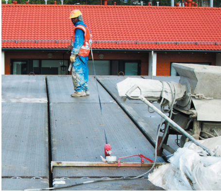
Kuva 3. Laatta-asennuksessa on käytettävä henkilökohtaista putoamissuojausta.
