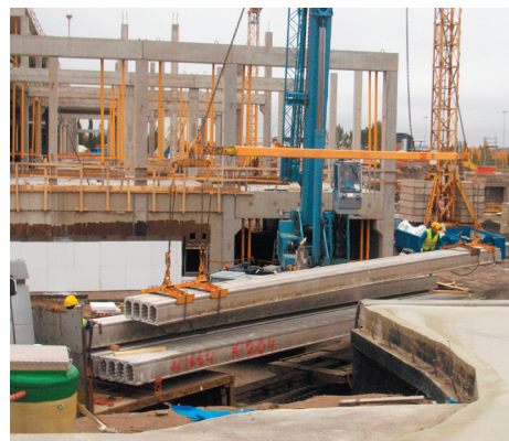
Kuva 9. Ontelolaatan nostoissa käytetään nostopuomia, joka on varustettu nostosaksilla ja varmuusketjulla.
