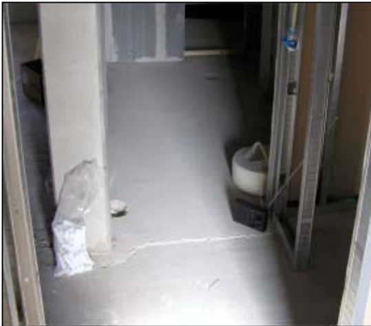
Kuva 20. Märkätilan lattia on valettu holvin saumavalujen yhteydessä. Menetelmällä saadaan betonille lisää kuivumisaikaa ja seuraaville työvaiheille hyvä lähtökohta.
