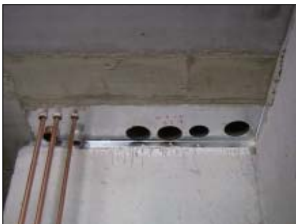
Kuva 9. Esivalmistetut läpimenokappaleet helpottavat tiiviin holvin aikaansaantia. /Kuva Jouko Finne/.
