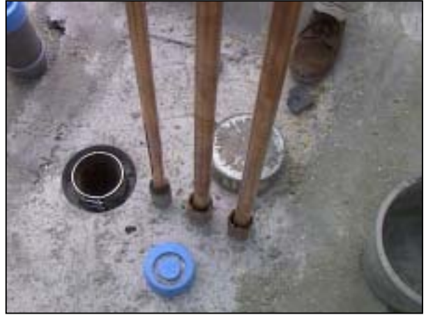
Kuva 14. Esivalmistetulla hormielementillä saadaan tiivis ratkaisu nopeasti valmiiksi.
