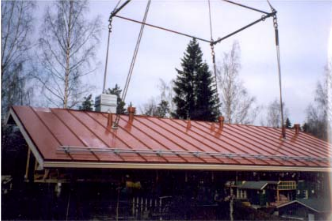
Kuvat 25. Karri Kortelainen (Skanska Oy) on toteuttanut useissa kohteissa maassa valmistamisen periaatetta.
