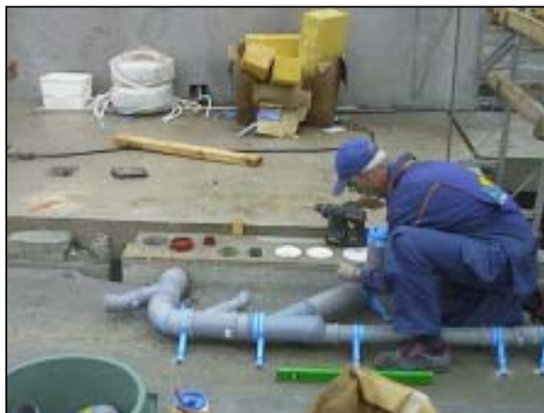
Kuva 12. Esivalmistettuun hormiin liitetään työmaalla esivalmistettu viemärihajotus /Kuva Jouko Finne/..
