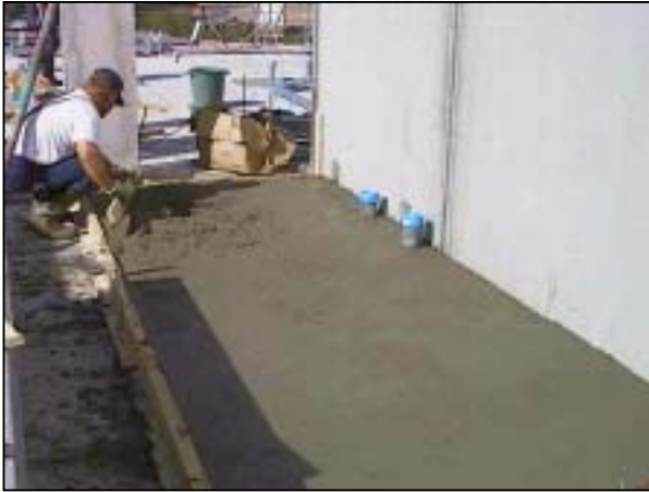
Kuva 13. Märkätilan lattian valaminen rungon nostamisen yhteydessä pidentää betonin kuivumisaikaa merkittävästi.
