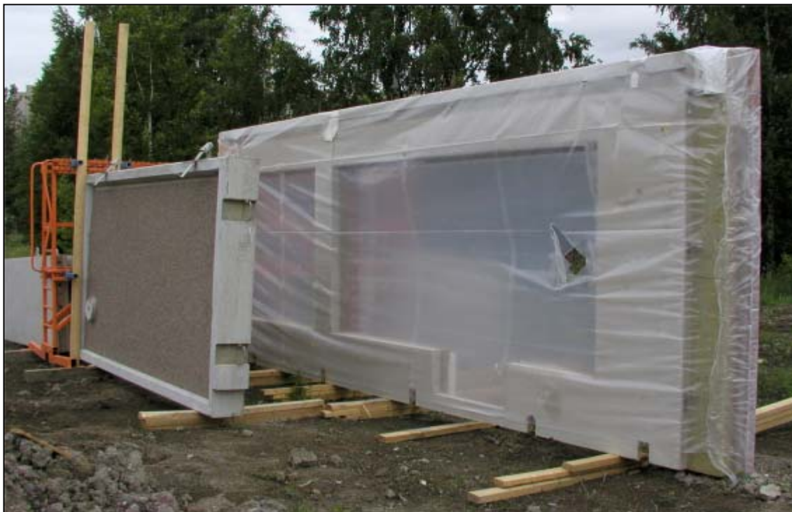
Kuva 5. Valkobetonipintaisia elementtejä lukuun ottamatta elementit voidaan suojata myös muovihupuilla. Mielipiteet ratkaisun hyvydestä kuitenkin jakaantuvat.
