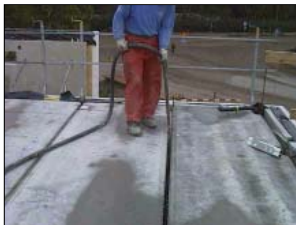
Kuva 10. Laataston vaakasaumapumpusta, jolla aikaansaadaan tiiviit saumat ilman tärytystä./Kuva Jouko Finne/.
