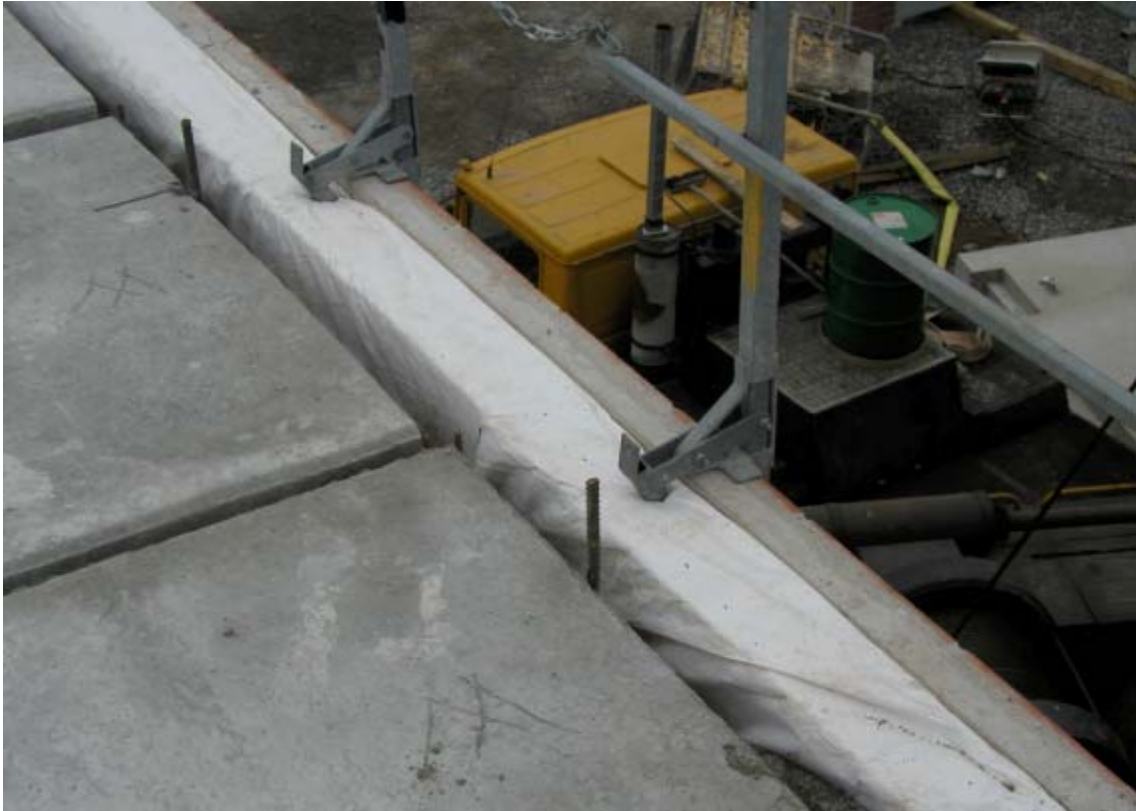
Kuva 16. Tutkimuksessa on kokeiltu Tyvek-tuulensuojakankaan käyttöä sandwichelementin eristetilän suojaukseen. Tyvek on hengittävä mutta vedenpitävä, muovikuitupohjainen muovikalvoa sitkeämpi kangas. Ensimmäiset kokemukset kankaan käytöstä ovat myönteisiä.
