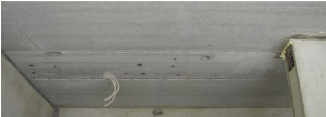
Kuva 22. Ontelovesien eliminointi vaatii kahdet vesireiät myös alle 3 m:n onteloihin. Kuvassa myös kololaatan syvennyksen viereen (kuvan keskellä) on porattu vesireiät.
