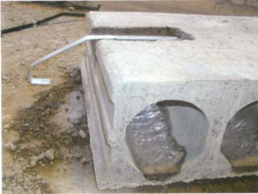
Kuva 23. Ruutuelementin kiinnityspisteeksi kehitetään onteloa rikkomatonta kiinnitystapaa. Koukku kiinnitetään ruutuelementissä olevaan vaijerilenkkiin.
