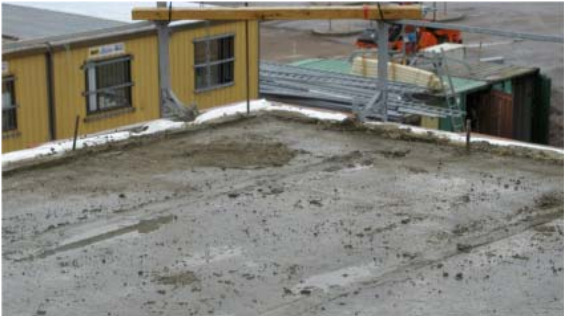
Kuva 17. Sandwichelementtien yläpään korkeusasema voidaan suunnitella 10-20 mm laataston pintaa ylemmäksi, millä padotaan tehokkaasti holvivesiä .
