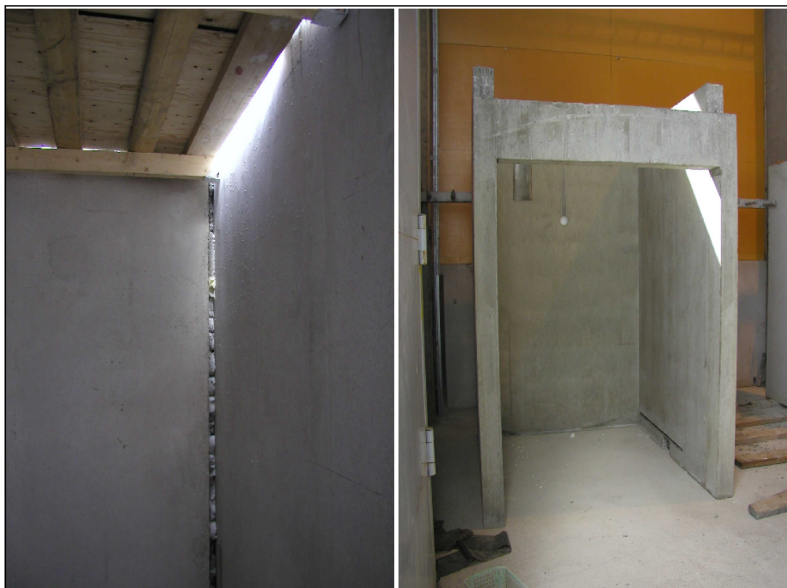
Kuva 15 ja 16. Vasemmalla perinteinen tapa toteuttaa hissikuiluja työmaalla ja oikealla Specifinn Oy:n tapa.
