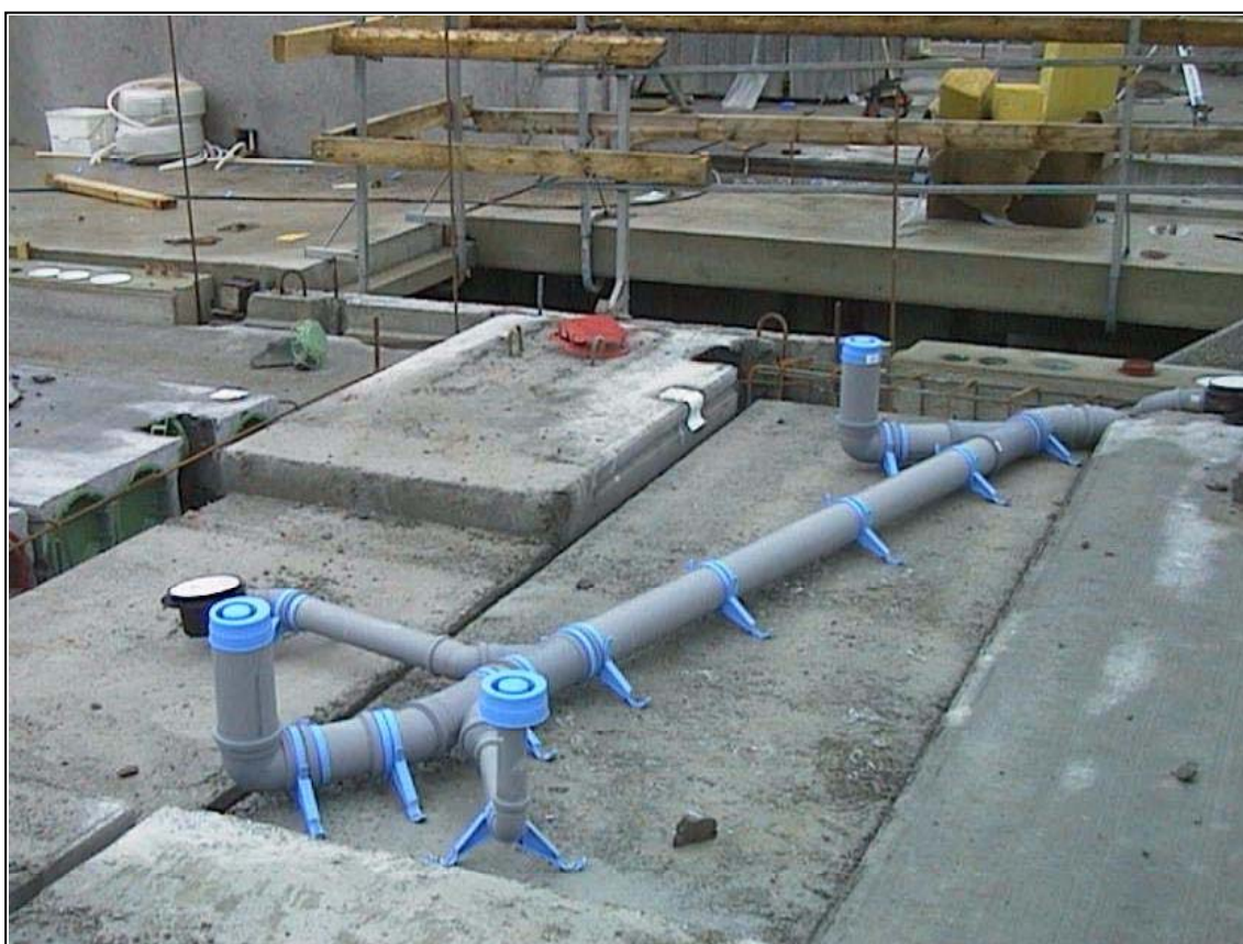
Kuva 14. Nykyiset ontelolaatat mahdollistavat muuntojoustavat ja toimivat märkätilaratkaisut. Märkätilan valaminen saumavalujen yhteydessä lisää betonin kuivumisaikaa.
