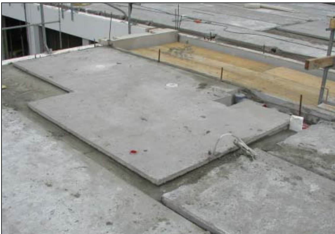
Kuva 17. Esivalmistettu märkätilalaatta asennetaan kololaatan päälle. Toteutustapa mahdollistaa joustavia suunnitteluratkaisuja.
