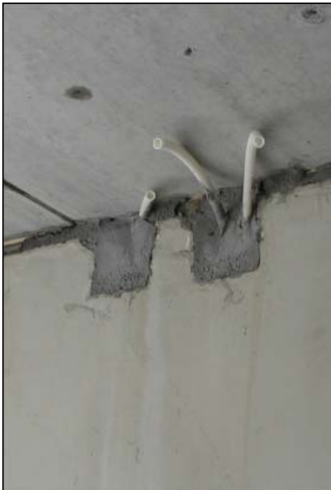
Kuvat 7 ja 8. Vasemmalla perinteinen väliseinäelementti. Oikealla sähkörasia on kiinnitetty valumuottiin magneetilla. Ratkaisu on valmistusteknisesti hyvä ja lopputulos on laadukas /kuva 8. Harri Bergholm/.
