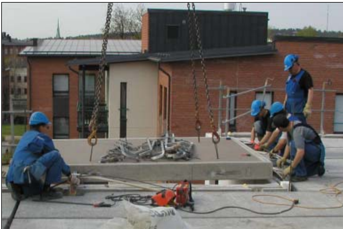
Kuva 4. Parvekkeiden asentamisessa esiintyy usein yllättäviä ongelmia.
