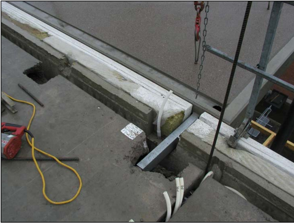
Kuva 6. Esimerkki eri järjestelmien yhteensovittamisesta. Vaikka piikkaustyö on pieni, sen vaikutus työn tehokkuuteen on suuri. Esimerkiksi torninosturi on paikoillaan piikkauksen ajan. Asennusryhmän muiden jäsenten työskentelyn tehokkuus myös laskee.
