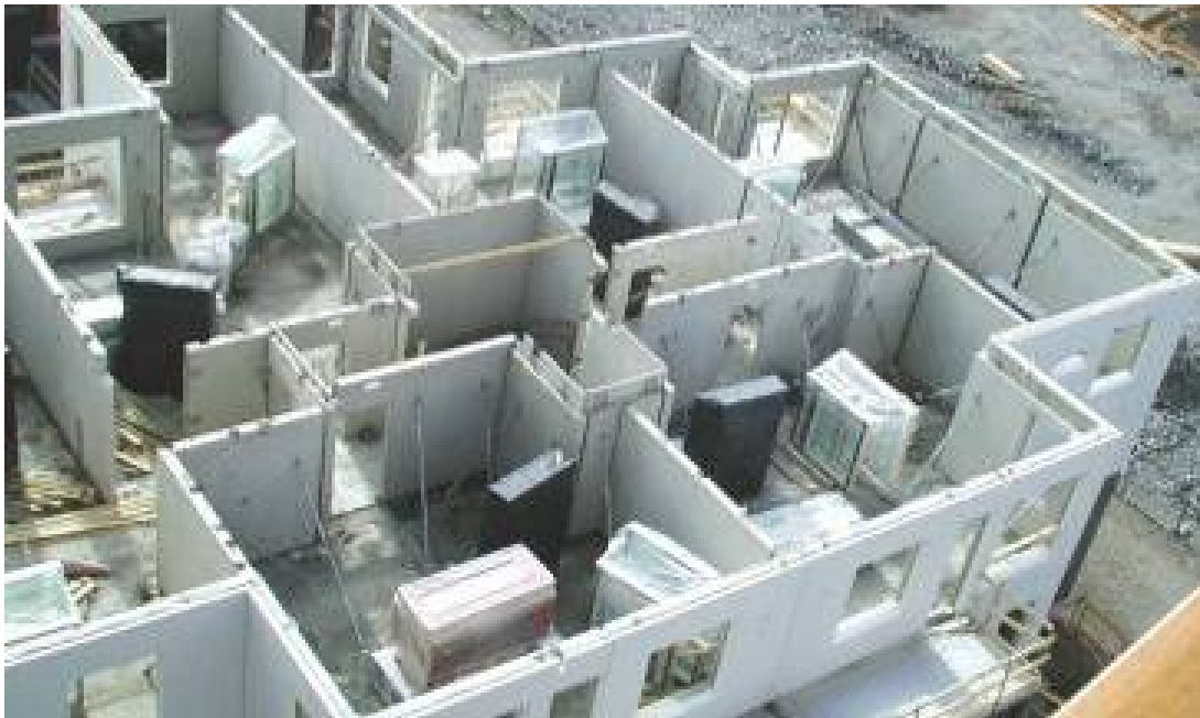
Kuva 11. Ikkunat nostetaan nykykäytännössä holville ennen seuraavan kerroksen ontelolaattojen asentamista. Muita holville varastoitavia rakennustarvikkeita ja -osia ovat esimerkiksi saunaelementit, rakennuslevyt, väliseinärangat ja lämpöpatterit.
