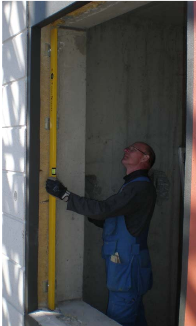
Kuva 8. Ikkunoiden kiinnittäminen elementtiin suositellaan tehtäväksi karmikenkäkiinnityksellä. Karmikenkiin ruuvattavilla pulteilla varmistetaan asennusaukon alapuolen vaakasuoruus ja toisen sivun pystysuoruus. Ikkuna saadaan näin ristimitaan eikä kiinnitysalusta elä niin kuin puukehystä käytettäessä tapahtuu kosteusvaihteluiden seurauksena. Tehdasasennuksessa on erityisesti huomioitava, että ikkuna on ”vaaterissa” elementin asentamisen jälkeenkin.
