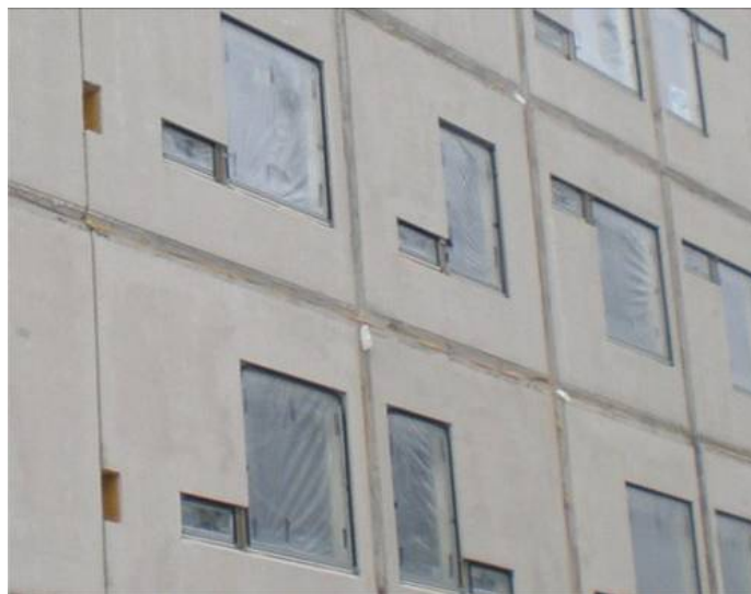
Kuva 10. Ikkunallisten elementtien suojaus rappausroiskeilta on myös tehty tehtaalla. Elementtien kohdistaminen paikoilleen tehdään sisäpinnan mukaan, kun ikkunat on asennettu tehtaalla.
